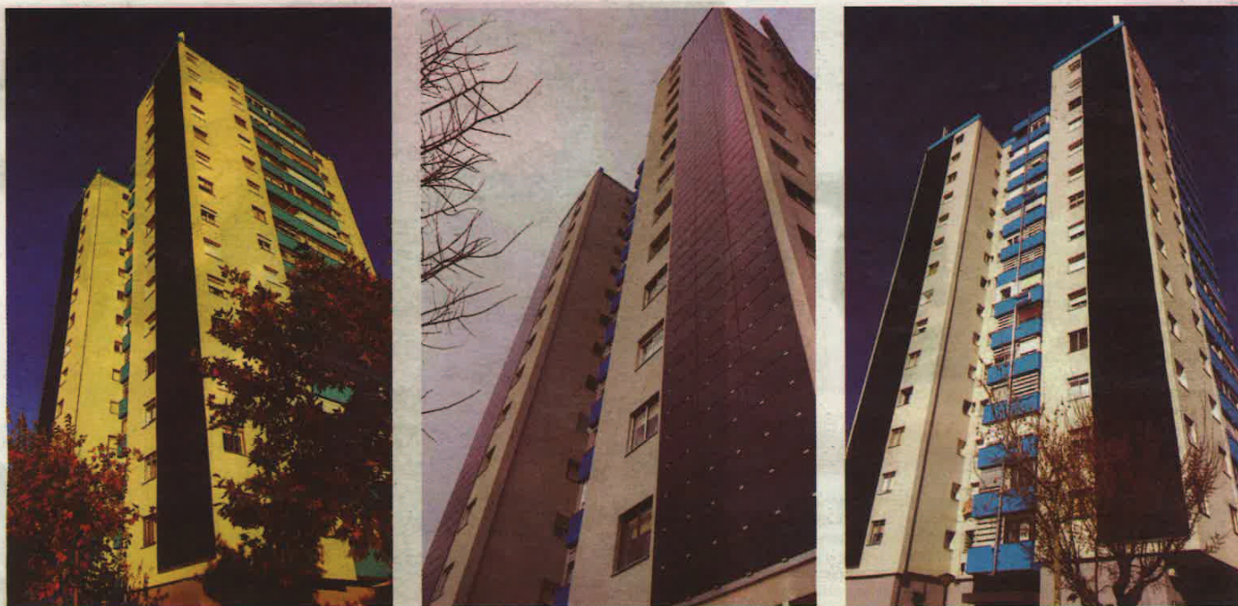
DIFERENTES PERSPECTIVAS DE LA FACHADA VENTILADA FOTOVOLTAICA, CAPAZ DE PRODUCIR ANUALMENTE 27.808 KILOVATIOS POR HORA. / EL DÍA DE VALLADOLID
